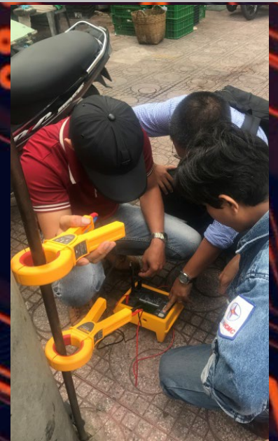
Đo điện trở đất
