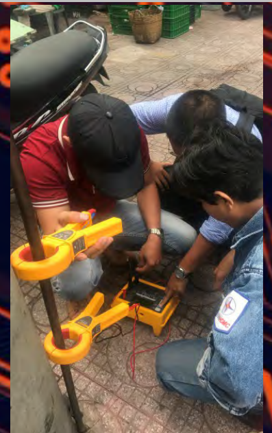
Đo điện trở đất
